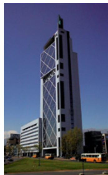
图 13 竣工后的 Telefónica 大楼
