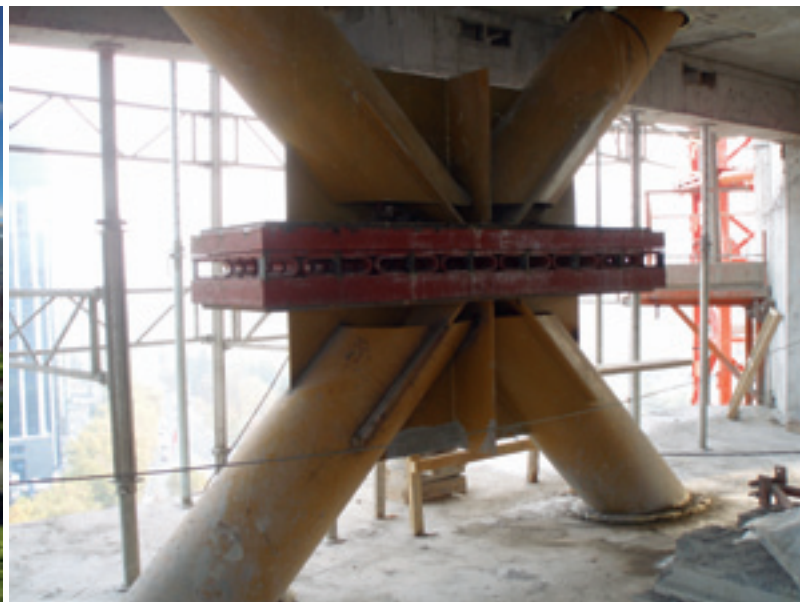
图 19 Titanium 大楼的能量消散器
