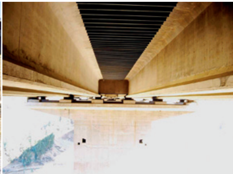
图 11 Marga Marga桥的弹性支撑物
